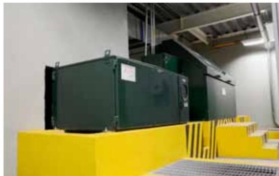
↑ **Adecuación.** Para la acometida se integra una celda de media tensión doble de entrada y salida
