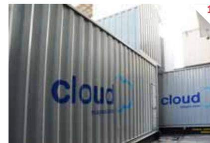
**1 Respaldo.** Dos plantas de emergencia ofrecen 48 horas de autonomía para soportar la operación de los equipos de misión crítica
