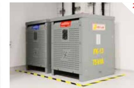
**2 Carga.** Dos transformadores tipo seco en distribución redundante se encargan de brindar la energía necesaria para las labores
