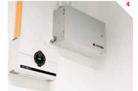
**4 Prevención.** El sistema Vesda para detección temprana de incendios permite evitar la propagación de fuego mediante monitoreo de gases
