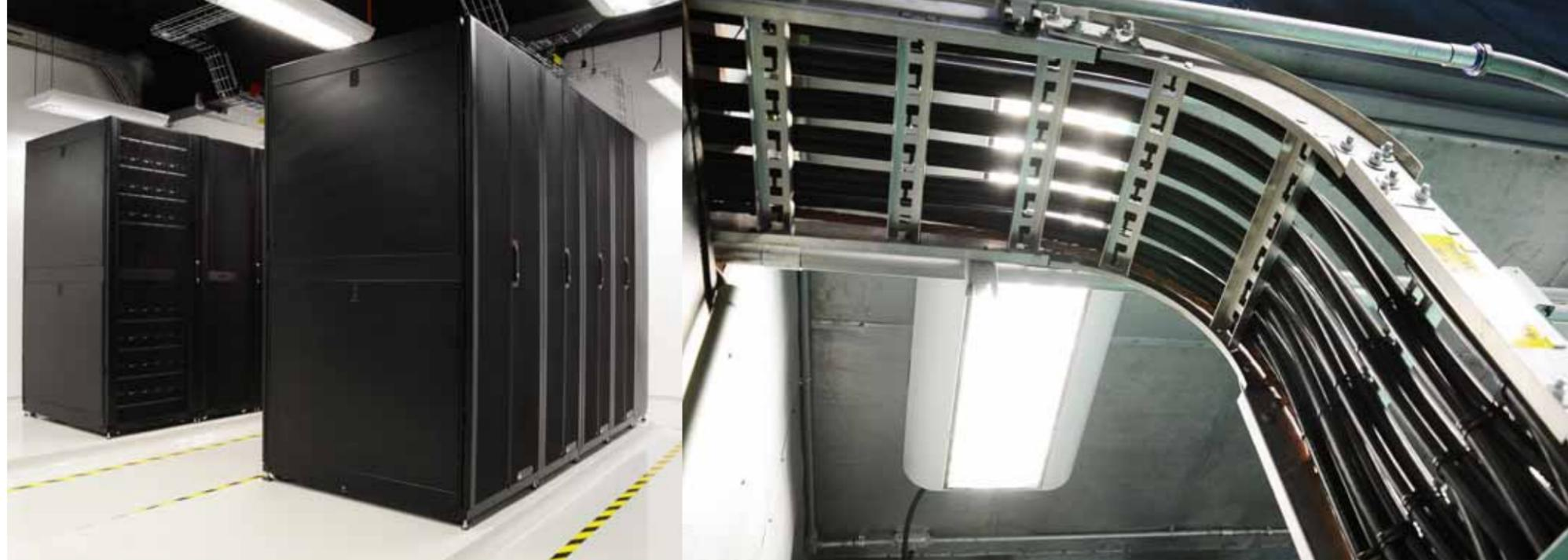
◀ **Canalización.** El cableado que brinda energía descansa sobre charola metálica, aterrizada mediante cable de cobre desnudo
